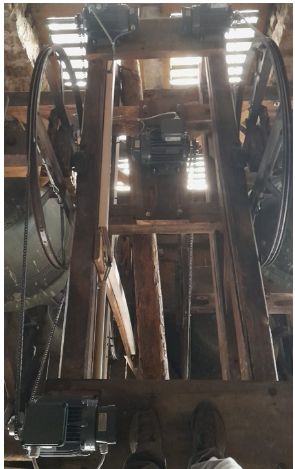
Antriebsmotoren der 4 Glocken
